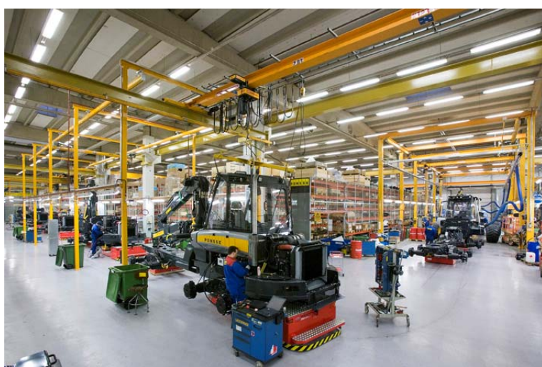
Nytt monteringsanlegg i Vieremä, 2005
